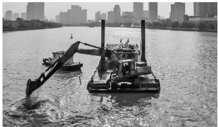
挖泥船正在三江口作业。记者 刘波 摄
