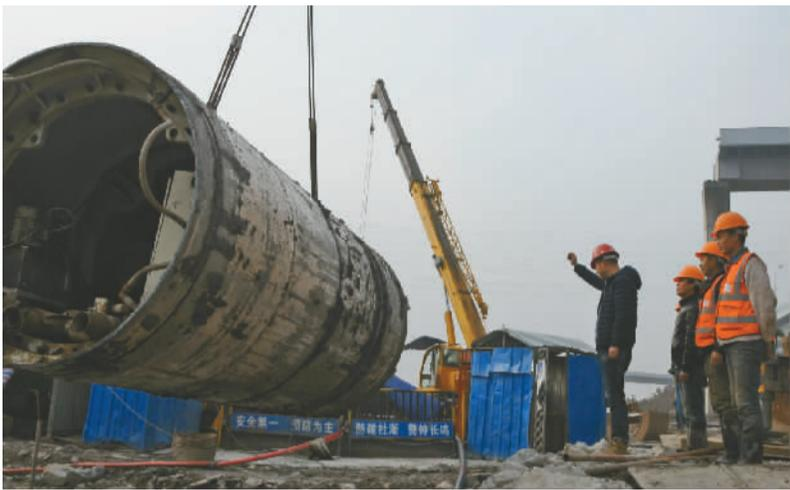
本报讯(记者 边城雨 通讯员 魏光华) 昨天上午10时许,桃源水厂出厂管工程北外环支线25号沉井至22号接收井段总长1517米的DN2020供水主干管顶管顺利实现贯通。据宁波市城管供水部门负责人周正协介绍,该段顶管工程创造了浙江省大口径供水管道单头顶进的长度新记录,也是桃源水厂出厂管线工程的一个重要节点性工程。
