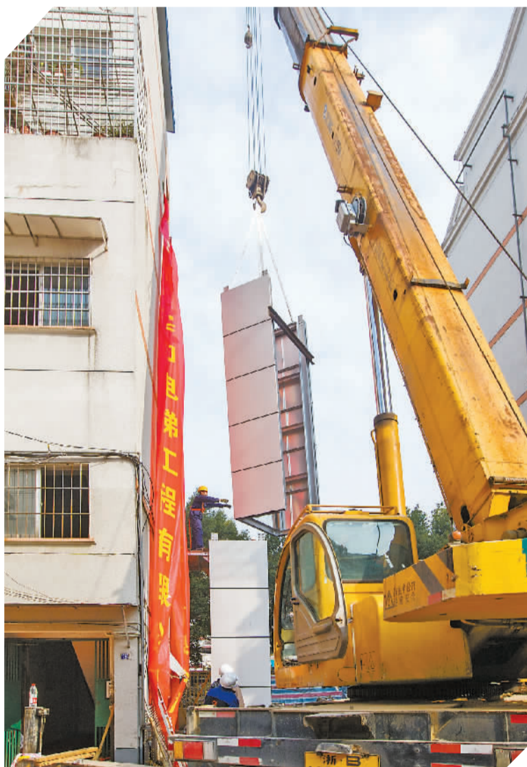
电梯吊装现场。 刘波 忻之承 摄
