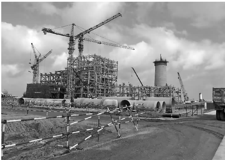
巴基斯坦胡布电厂援建工地。
