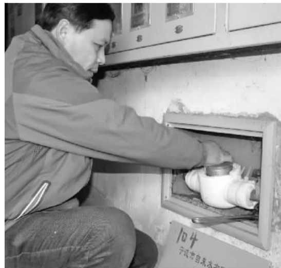
储世斌在抢修供水设施。
