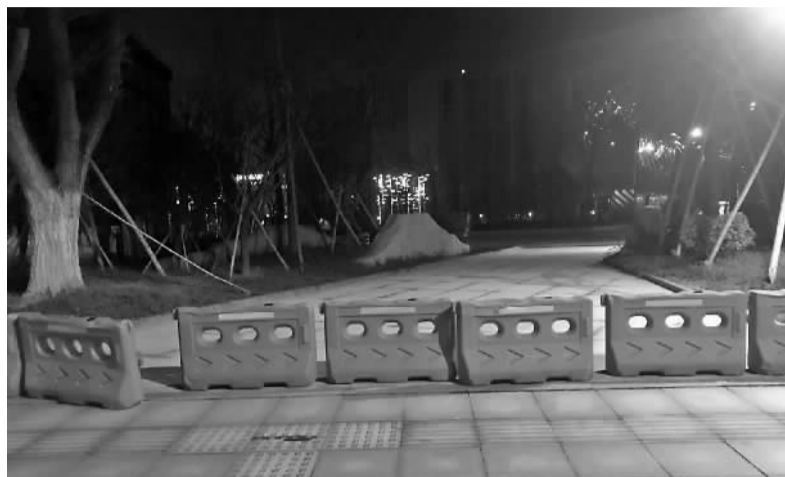
有些地方施工设施还没有拆除。
