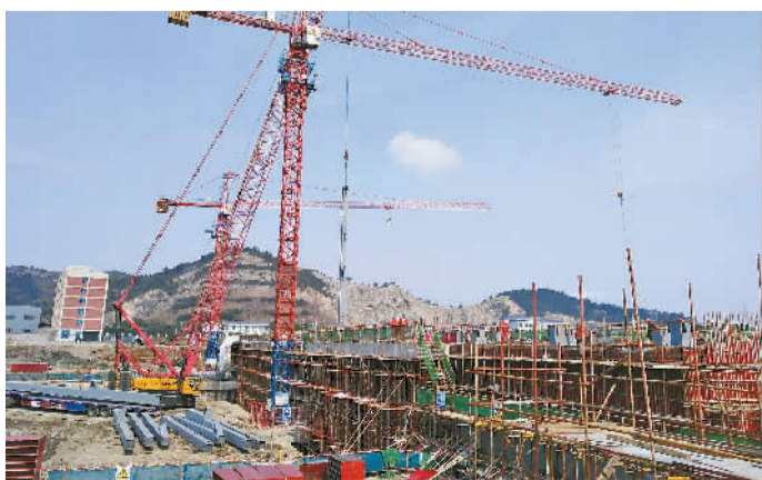
正在建设的姚江二通道(慈江)工程
