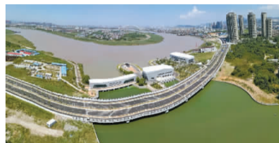
甬新闻强排泵站
