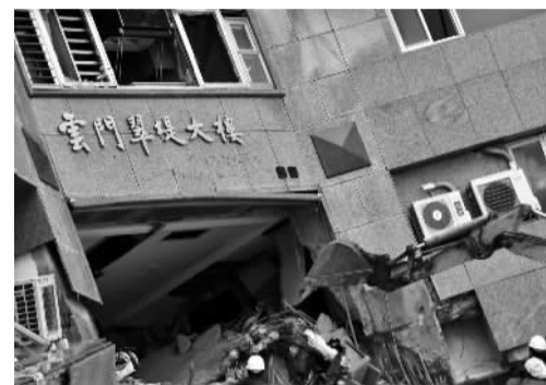
2月8日,救援车辆在花莲云门翠堤大楼进行挖掘。 新华社发
