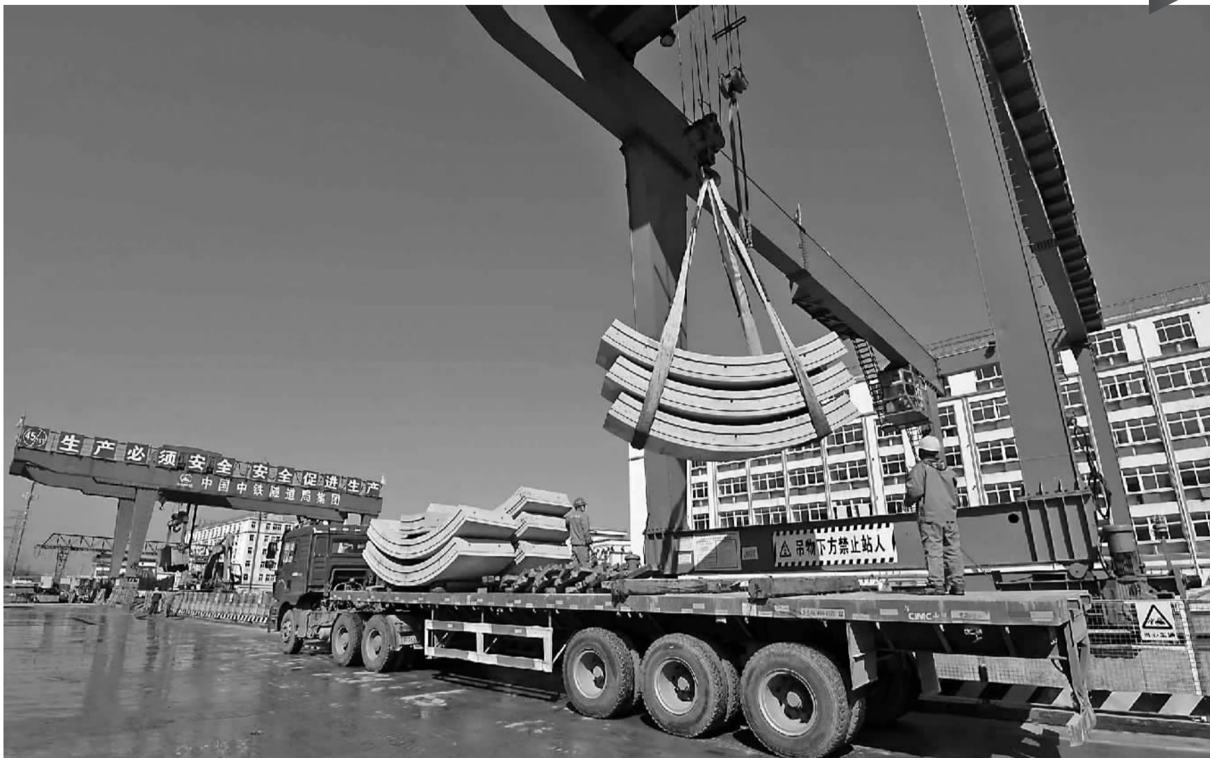
热火朝天的轨道交通4号线施工现场。记者 徐文杰 摄
