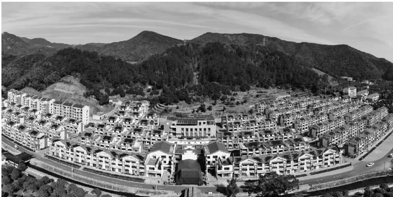
海曙区龙观乡李岙村家家户屋顶上都安装了光伏板。 记者 唐严 摄
