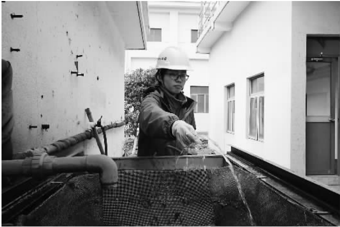
忍着恶臭与脏污，李倩倩清理污水过滤水槽。
