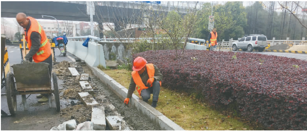
前天,工人们在丽园南路丽安桥上施工。
