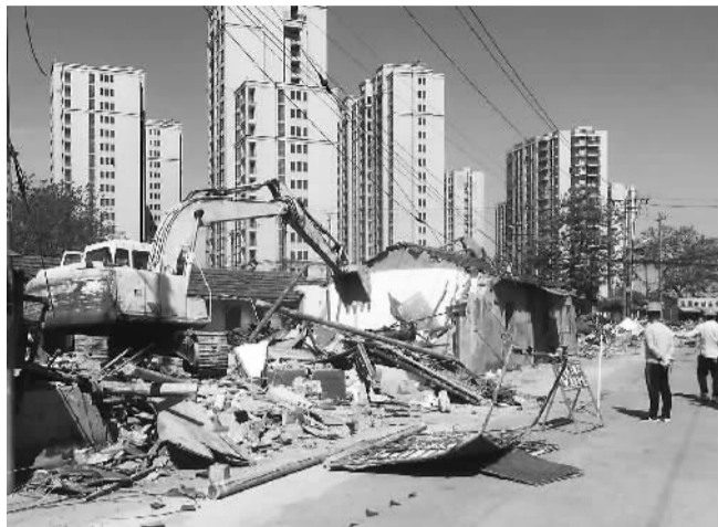
违建拆除现场。
