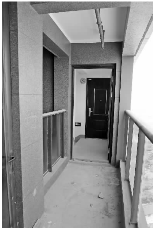
半买半送的阳台其实为消防前室。
