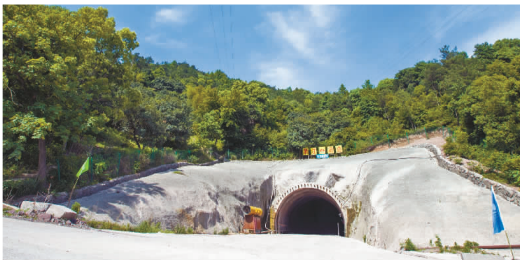
昨日,桃源水厂1#出厂管线实现双向贯通。 记者 刘波 通讯员 张良 摄
