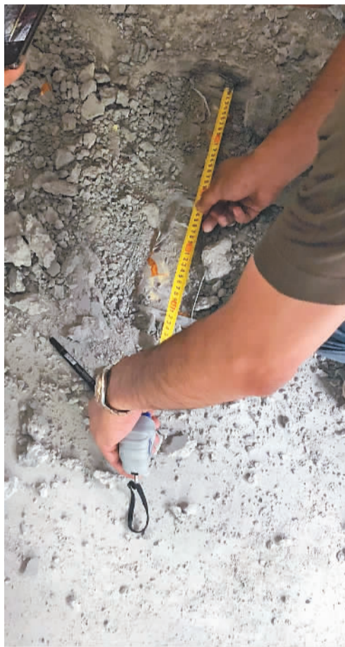
凿开地面，测量地暖管道间距。
