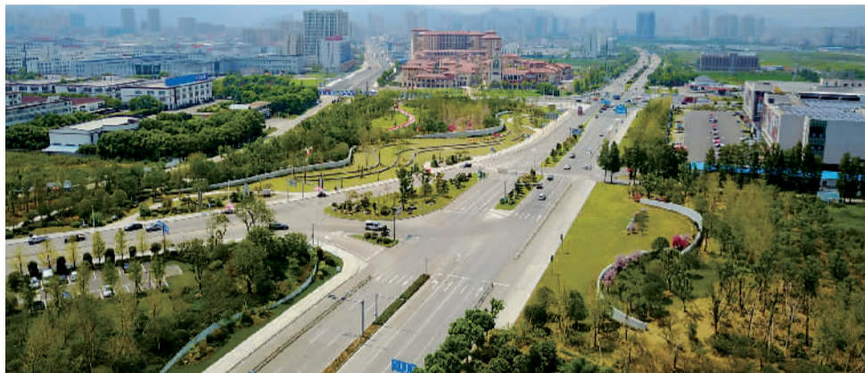
高速公路西坞入城口。
