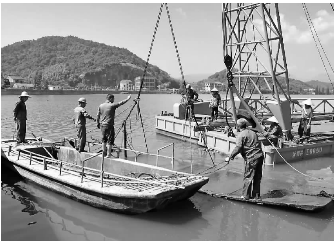
打捞沉船作业现场。
