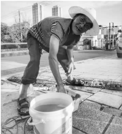
宋爷爷在修理桥面。
