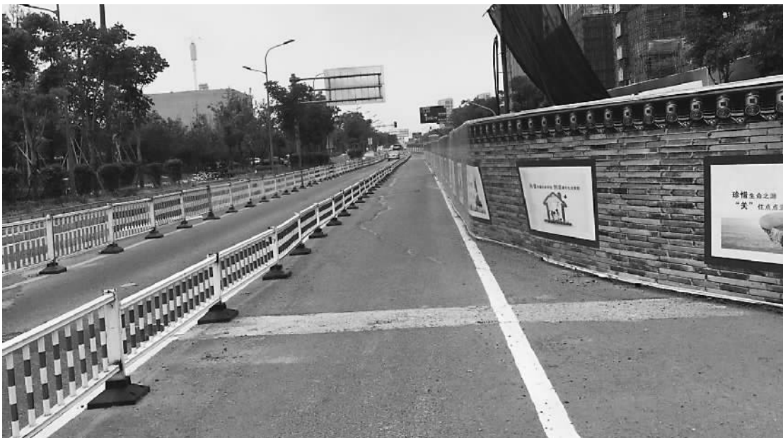
首南西路(它山堰路至惠江路)只留下半幅道路通行。
