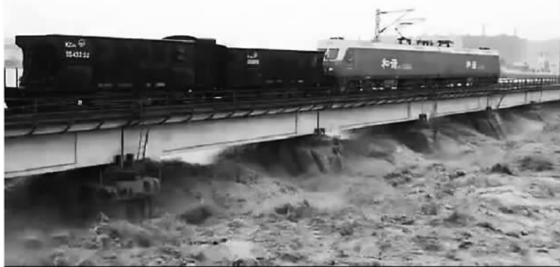
两列重载货物列车开上涪江大桥“重车压梁”抗洪。
