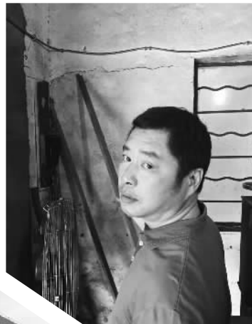
潘先生家房子的裂缝
