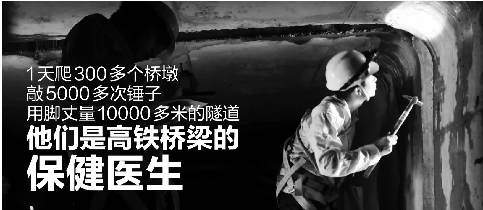
肖伟华用检查锤敲击混凝土连接处。
