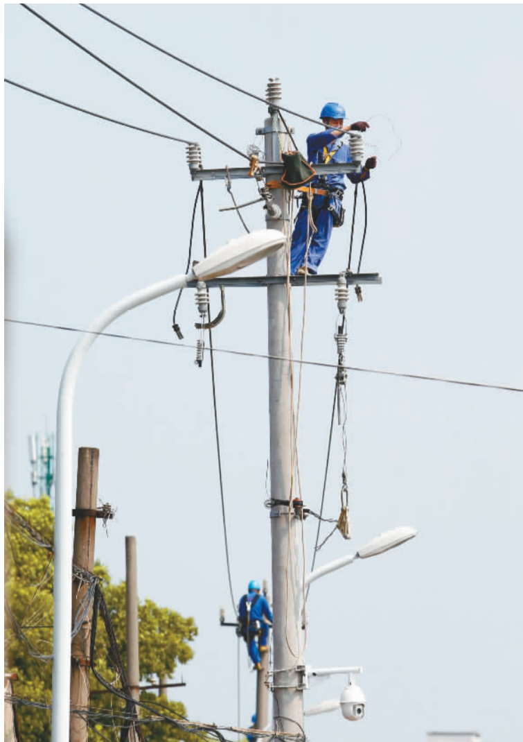
电力职工在施工。
