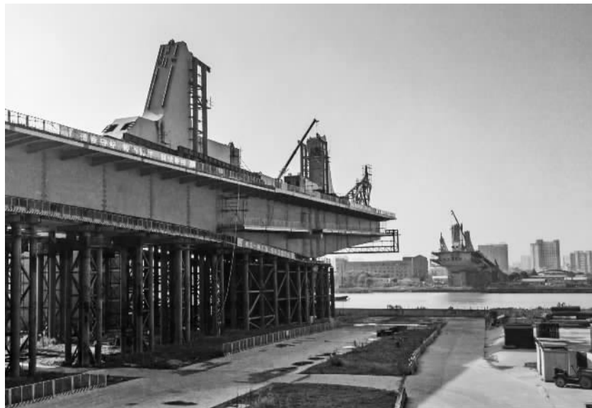
施工中的中兴大桥。记者 刘波 摄
