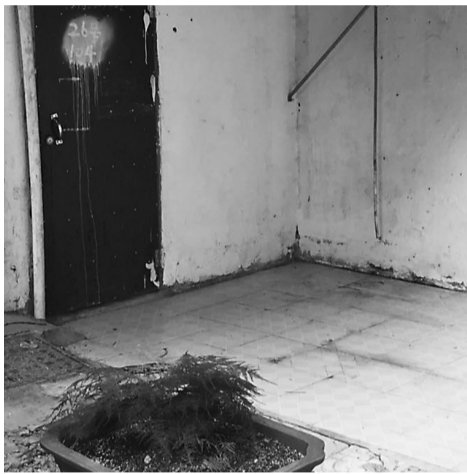
整治后的车棚焕然一新。
