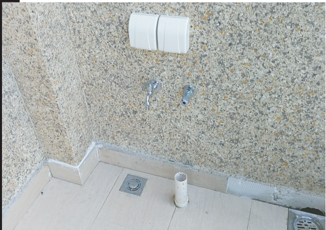
顶楼的阳台配备有插座和下水管,本来可以安放洗衣机。
