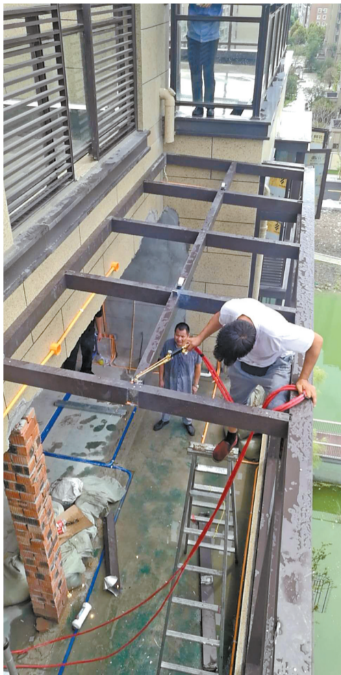
工人对违法搭建进行拆除作业。
