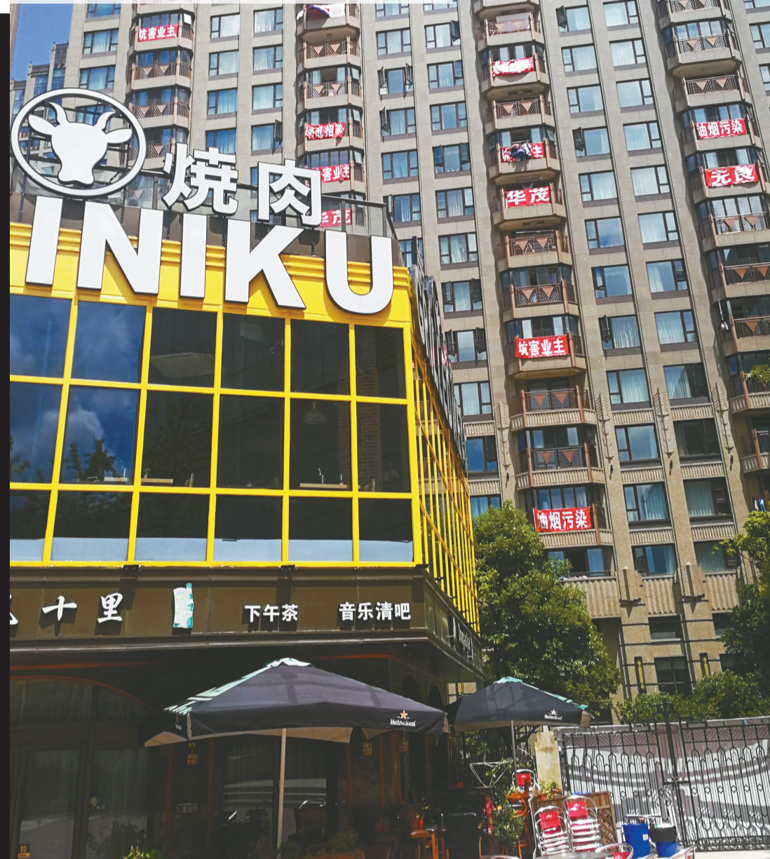
华茂悦峰很多住户的阳台挂出了横幅，上面写着“油烟污染，坑害业主”等字样。
