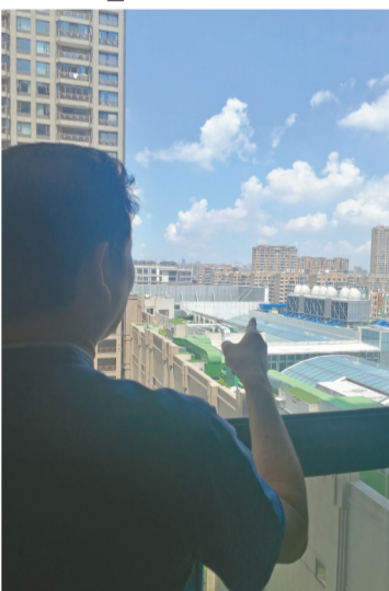
从业主家的窗户可以看到明州里楼顶的管道和简易房。
