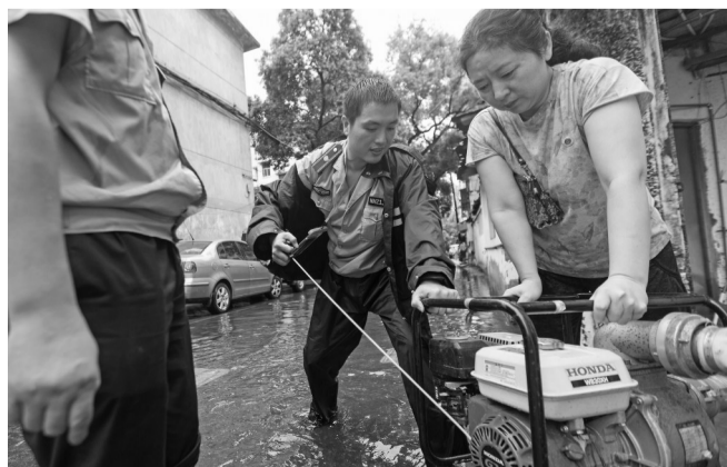
昨天下午，工作人员正在对积水严重的海曙文昌街76号进行排水作业。
