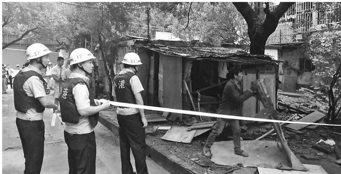
违建拆除现场。
