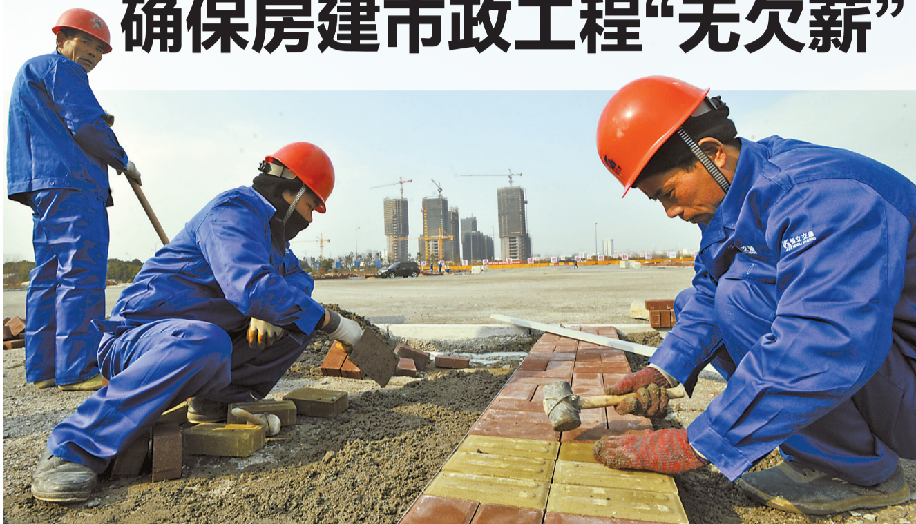
建筑工人在工地作业。记者 刘波 摄
