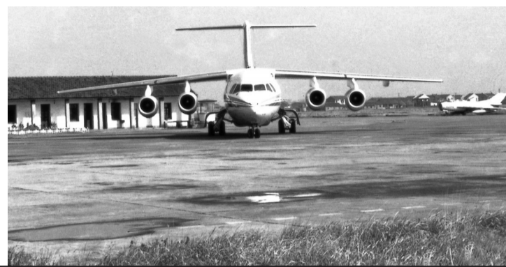
1984年11月16日,民航宁波站(庄桥机场)第一架飞机降落。
