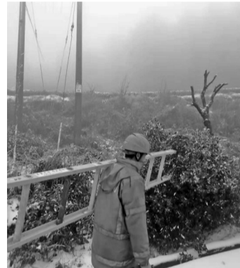
巡线员在梅岭山岗上巡线。
