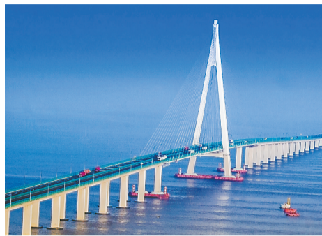
杭州湾跨海大桥。张关春 摄
