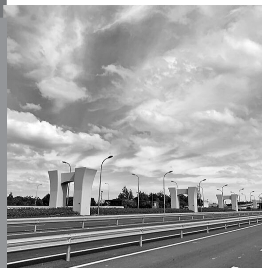
北外环快速路九龙大道连通工程。
