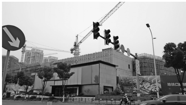
宝龙广场正在施工中,拟于今年开业。 记者 谢舒奕 摄
