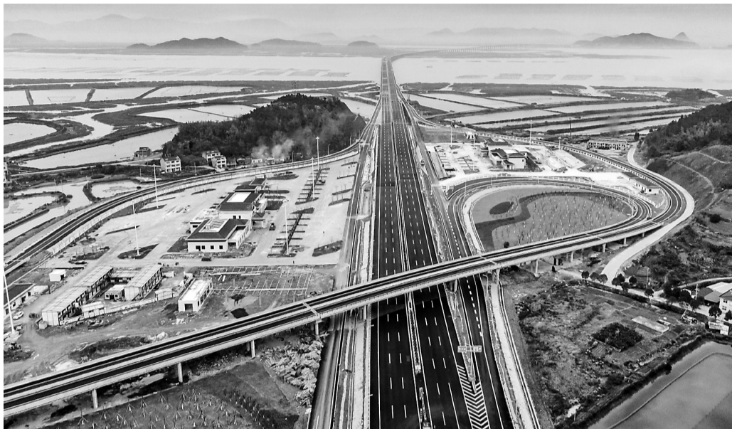
三门湾大桥及接线被誉为“最美沿海高速”。通讯员供图
