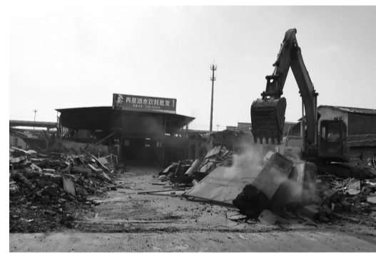
庄桥街道与铁路部门联合拆违。
