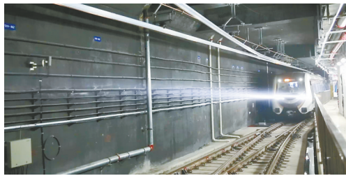
试验现场。图片由宁波轨道交通集团提供
