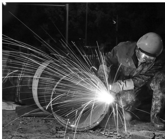
春节期间,施工人员在抢修供水管道。
