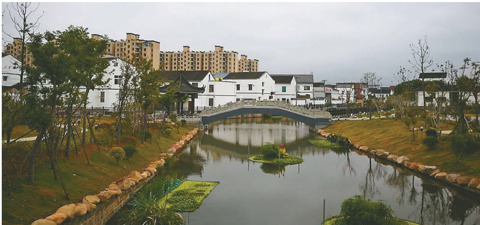
慈溪市白沙路街道轻纺村拆后建设公共绿地。
