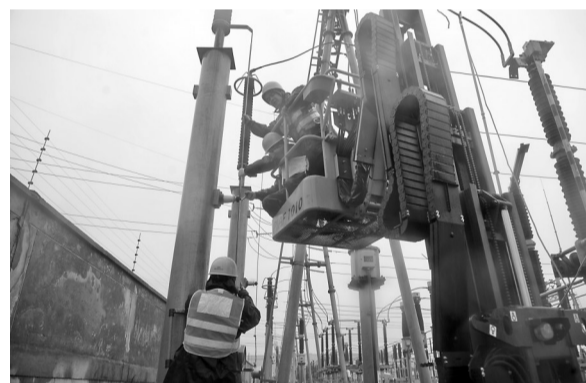
施工人员在检修。记者 崔引 摄
