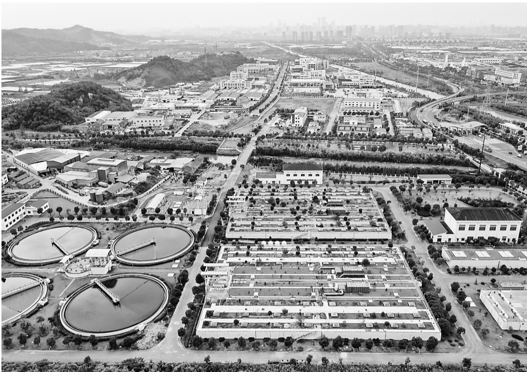
新周污水处理厂全景
