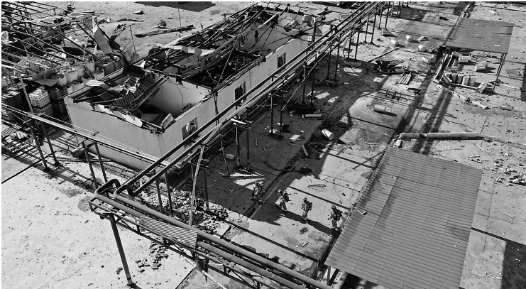
3月22日,消防队员在江苏盐城响水化工厂爆炸事故现场搜救(无人机拍摄)。 新华社发
