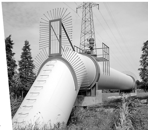
我市建成的大型工业供水管线。
