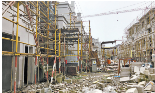
仁湖锦庭楼盘施工现场。
