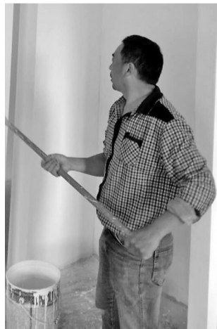
一处老宅改建工地上，李政玉正在粉刷墙面。
