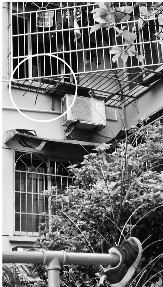
孩子应该是从二楼空调室外机旁断裂的钢筋处滑落的。
