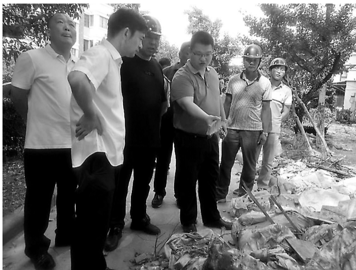
林天峰(左四)在金邑水岸小区改造工程现场督查。
